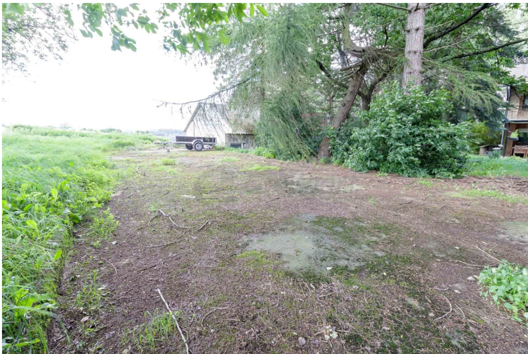
Fundamentplatte des alten Stalls
