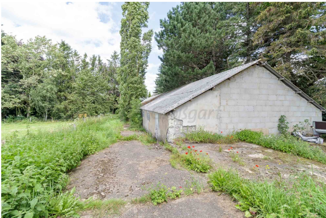
seitlicher Zugang Stallungen
