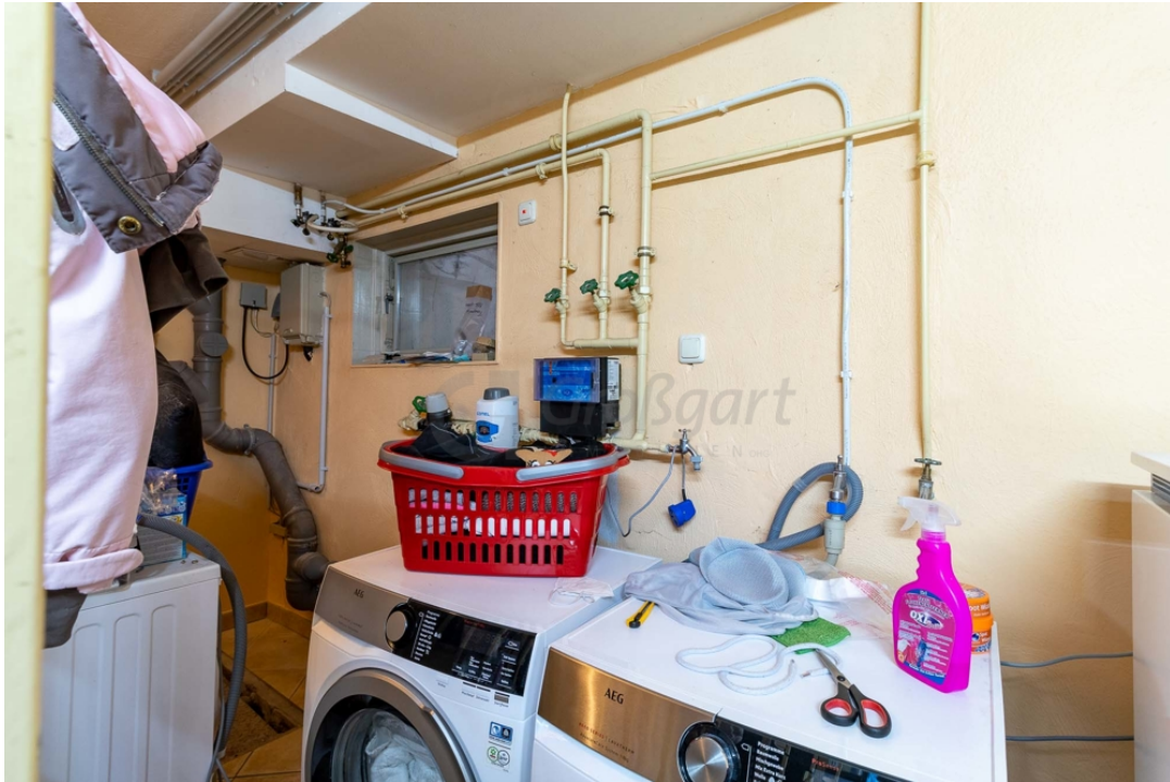
Waschküche m. Hausanschlüssen
