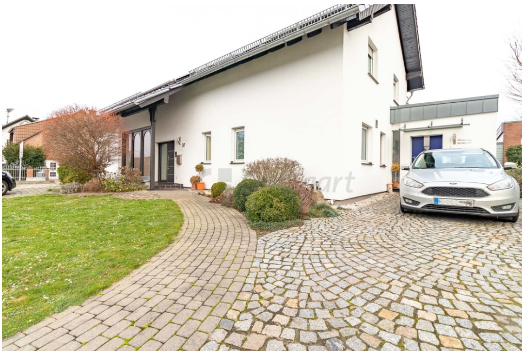
Zugang Wohnung DG
