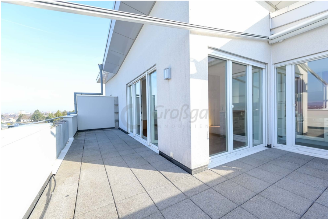
Terrasse mit Beschattungsanlage
