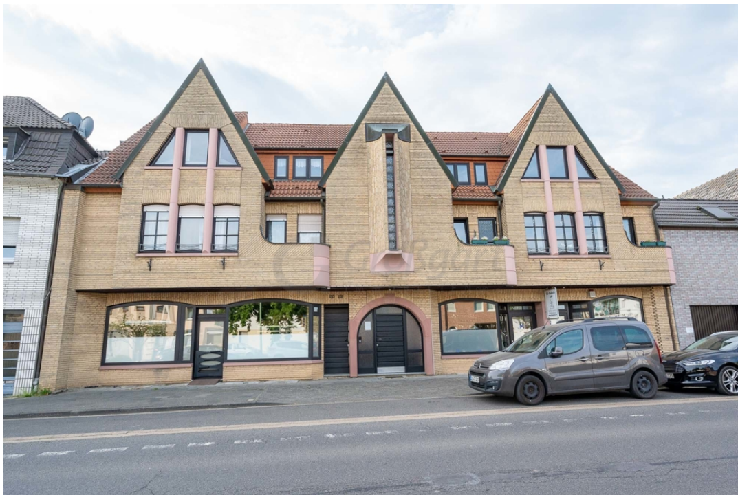
Ansicht von Strasse
