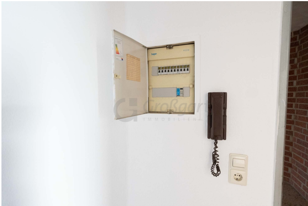
Sicherungskasten/Gegensprechanlage
