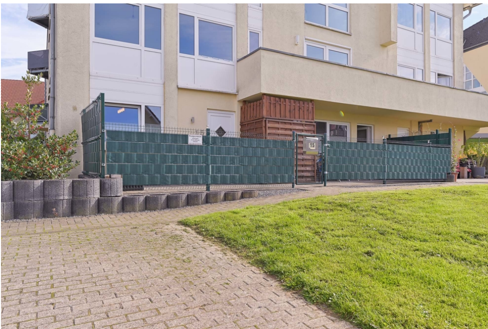
Ansicht von außen
