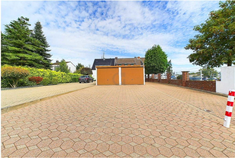
Blick von der Straße
