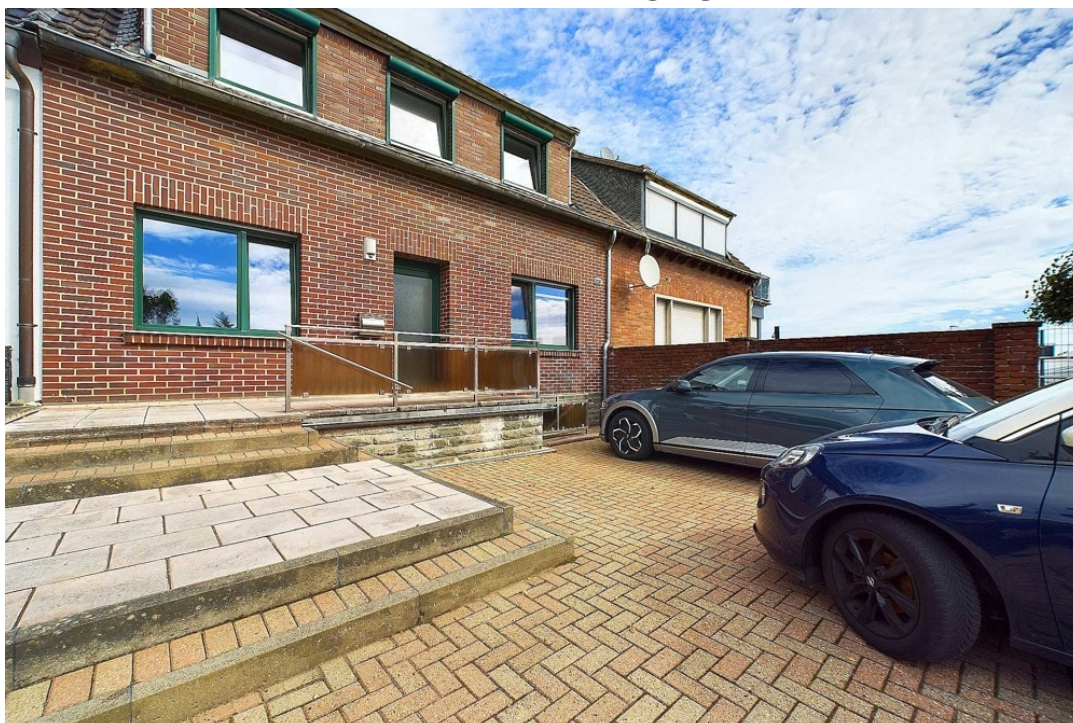
Frontansicht mit Zugang
