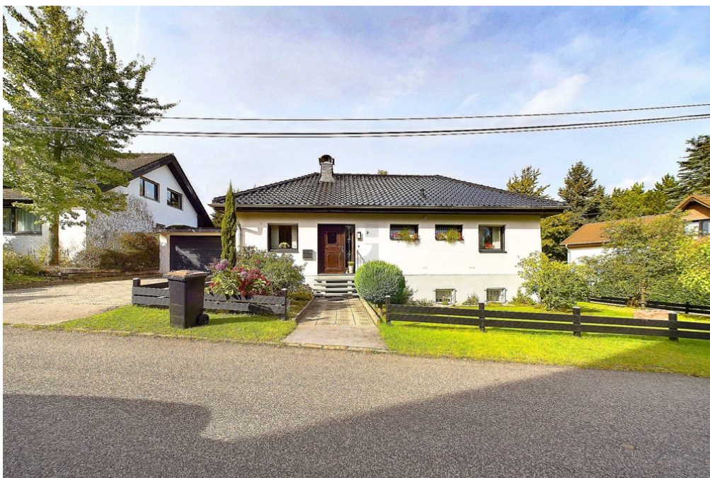
Ansicht von Straße
