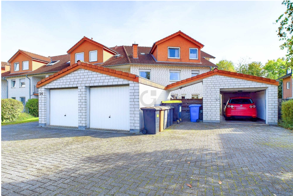
Ansicht Wohnhaus von Straße
