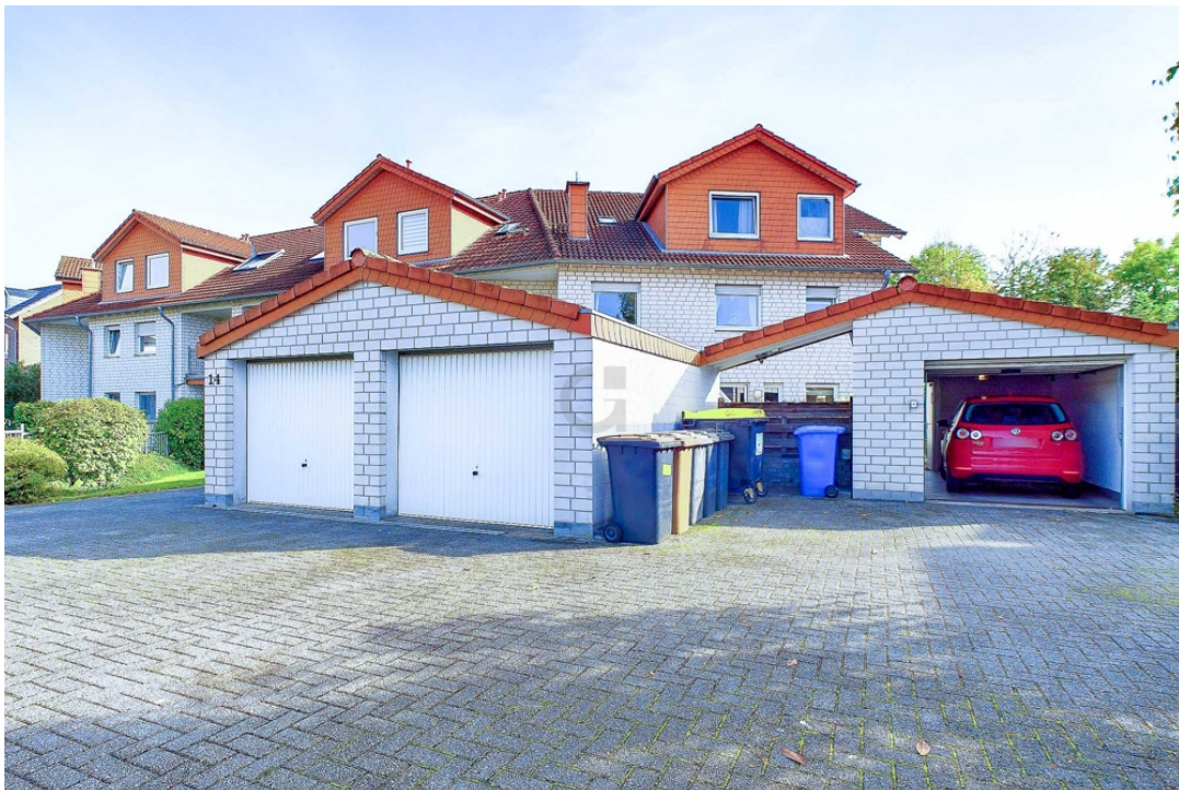
Ansicht Haus mit Garagen
