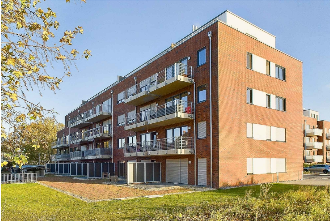
rückwertige Ansicht Haus 1-5
