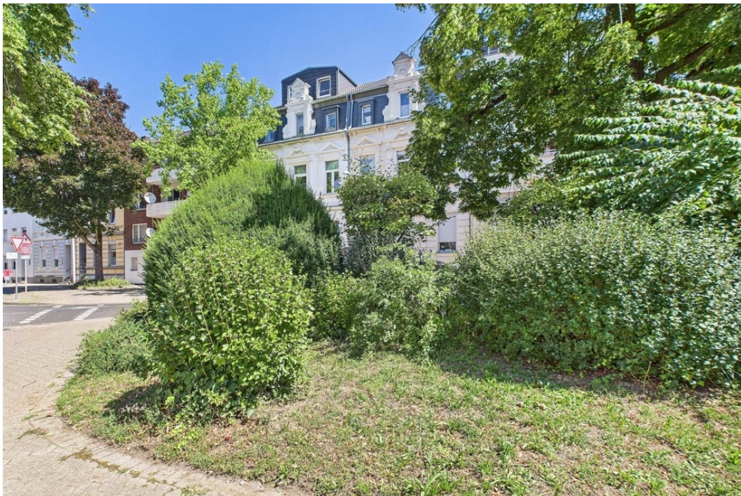
Blick auf das Dachgeschoss
